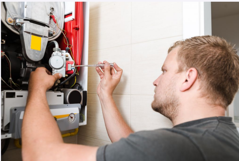
Figuur 7. Een monteur is bezig met een reparatie van een CV ketel
