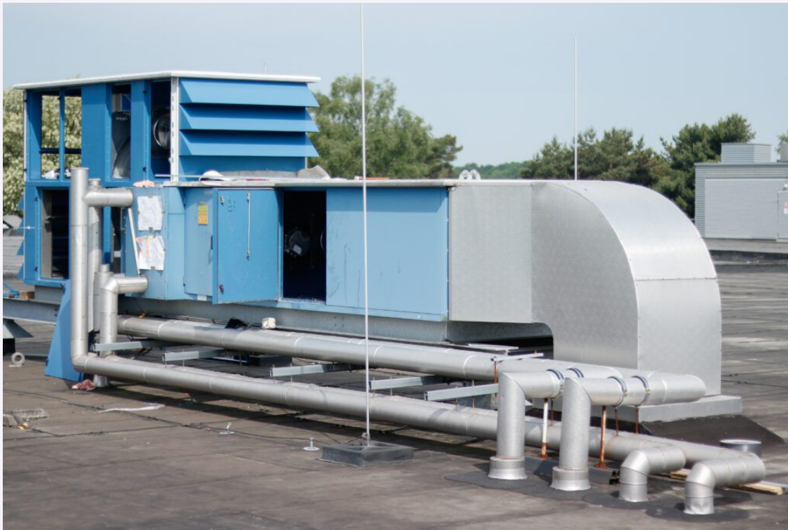
Figuur 9. Een refurbished luchtbehandelingskast van Orange Climate
